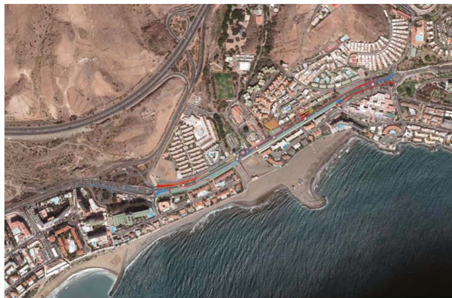
Bis Ende des Jahres 2019 soll das Teilstück zwischen San Agustín und der Autobahnabfahrt neu gestaltet werden. Die Ausschreibungsfrist endet am 11. März 2019.
